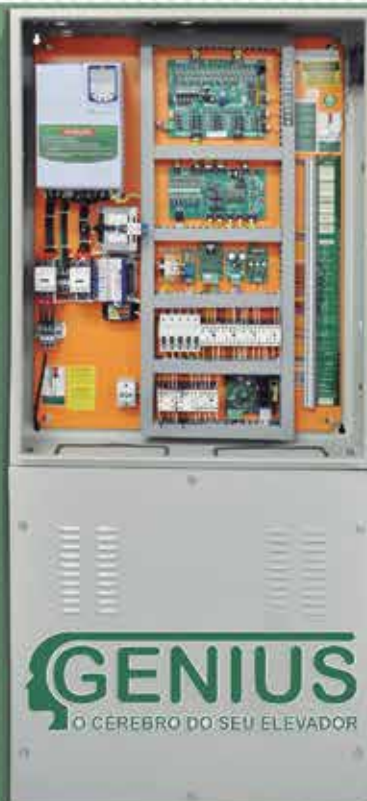
Depois da Modernização COMANDO NOVO
