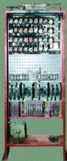
Antes da Modernização COMANDO ANTIGO
